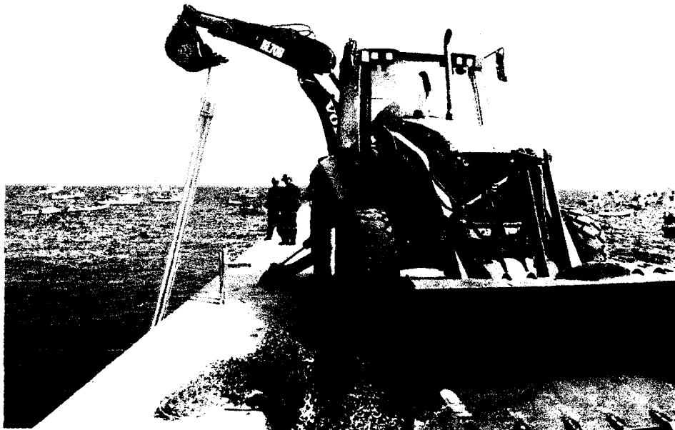
Foto N° 02: Posicionamiento de parantes para su hincado.
